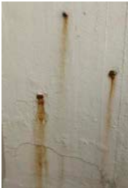
Corroded External Fixtures Gosodion Allanol wedi Cryddu
