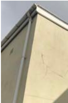
Cracking Render Rendro wedi Cracio
